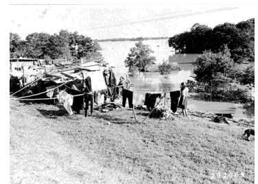
写真7-4 利根川の堤防上での避難生活（国土交通省関東地方整備局利根川上流河川事務所）
