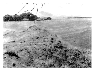
写真7-1 決壊口9月17日 10時ごろ下流天端より望む (国土交通省関東地方整備局 利根川上流河川事務所)
