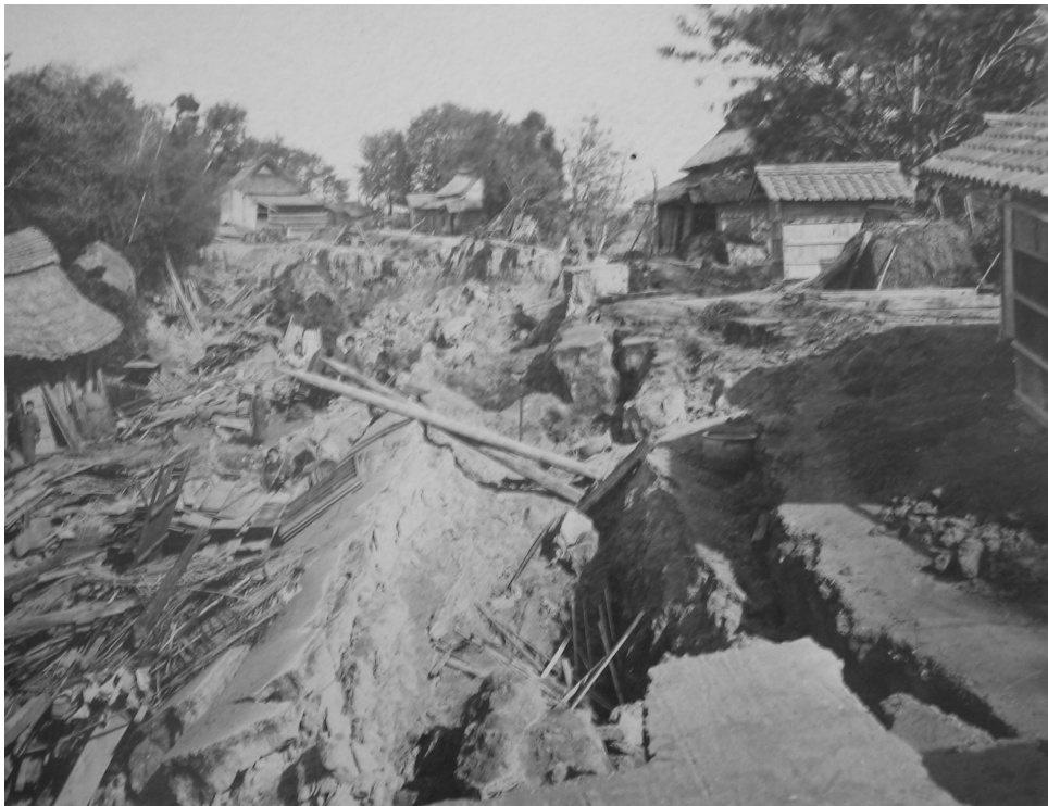
写真 1 - 28 下小田井村堤防の壊裂 (国立科学博物館所蔵)
