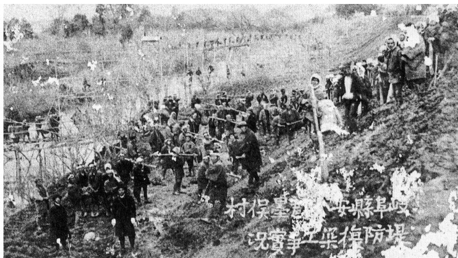
写真1-31 長良川堤防の復旧工事（奥田良二氏所蔵）
