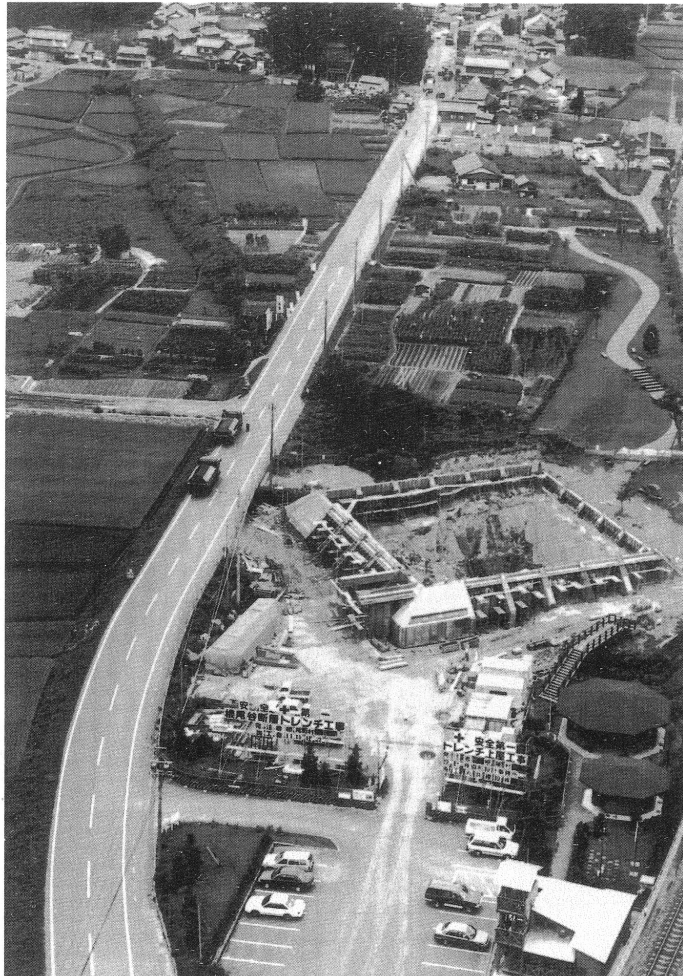
写真1-5 建設中の根尾谷断層地下観察館 (中日新聞社(1991年)撮影)
