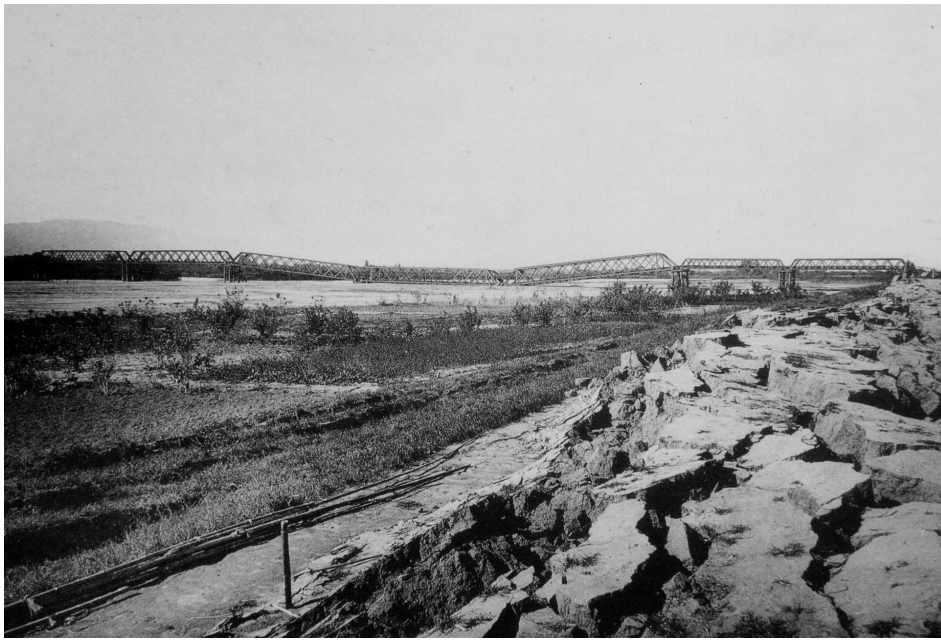
写真 1 - 27 長良川堤防の壊裂 (Milne&Burton. W. K. , The great earthquake in Japan, 1891)
