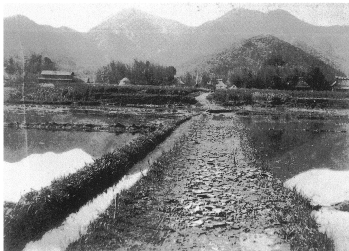
写真1-8 高富町森での道路の左横ずれと断層崖 (岐阜地方気象台所蔵(1929年撮影))
