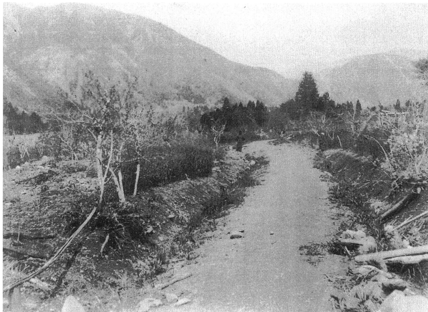
写真 1-2 旧根尾村中の道路の食い違い (岐阜測候所撮影、岐阜地方気象台所蔵)
