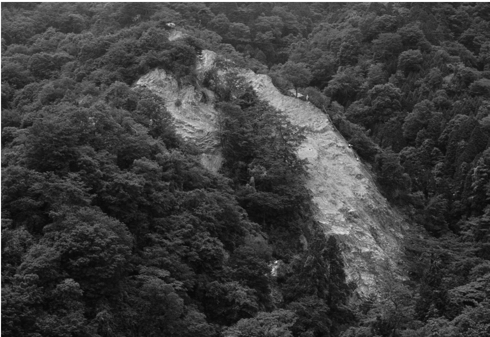
写真 1-17 地震による表層崩壊（神戸市）
