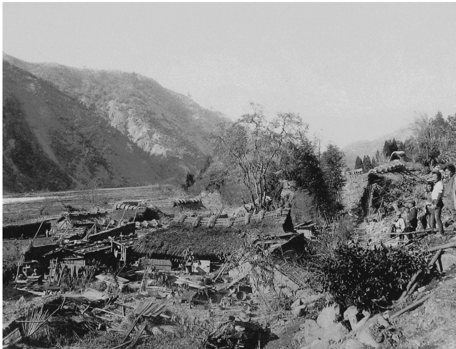
写真 1 - 20 根尾天神堂における陥没と家屋倒壊 (長崎大学附属図書館所蔵)
