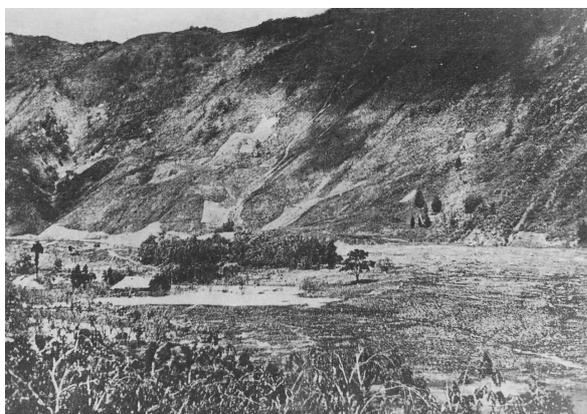
写真 4-13 被災直後の長坂地区（岩田善平撮影。竹内写真館所蔵）（写真左側が長瀬川上流、この周辺の両堰は流出土砂により被災した）
