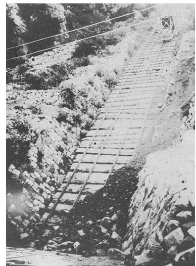
写真4-17 材料運搬軌道インクラインの施設（立山砂防事務所）
