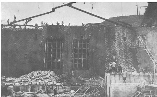
コンクリート打設及び積石状況並びに副堰堤型枠組立て状況
