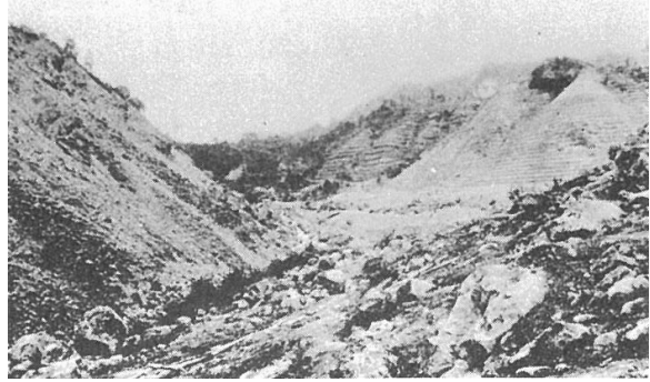
写真4-6 富山県砂防時代泥谷に施された 見事な植生工 (立山砂防事務所)
