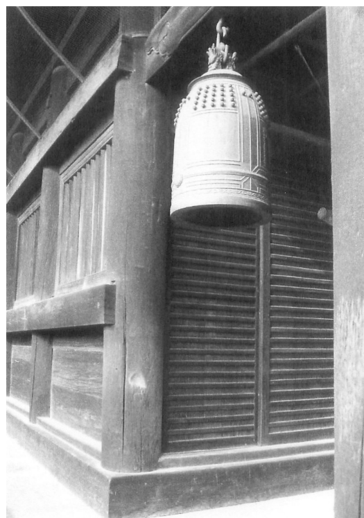
写真1-6 善光寺本堂南西隅の釣鐘と柱の傷 (善光寺事務局所蔵、鬼頭康之撮影)
