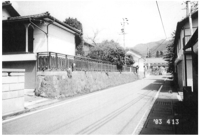
写真1-3 善光寺地震の地震断層の段差が石垣として残る（小松原）（赤羽貞幸撮影）
