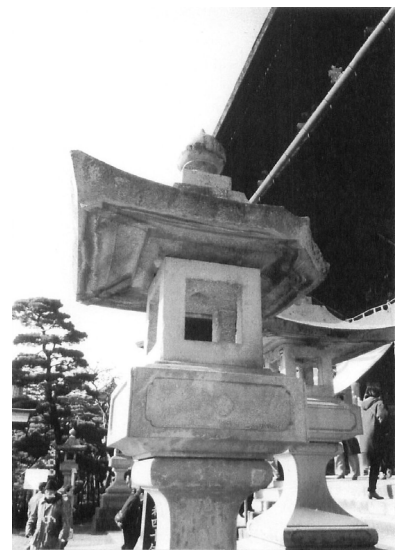
写真1-4 地震による倒壊で生じた石塔の破損（善光寺）（赤羽貞幸撮影）
