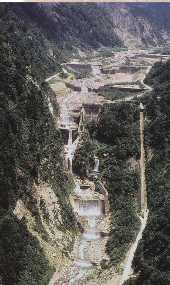
白岩砂防堰堤
