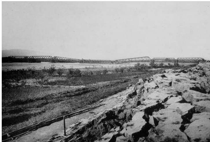
写真 5-3 長良川堤防の崩壊の様子(岐阜県歴史資料館所蔵)
