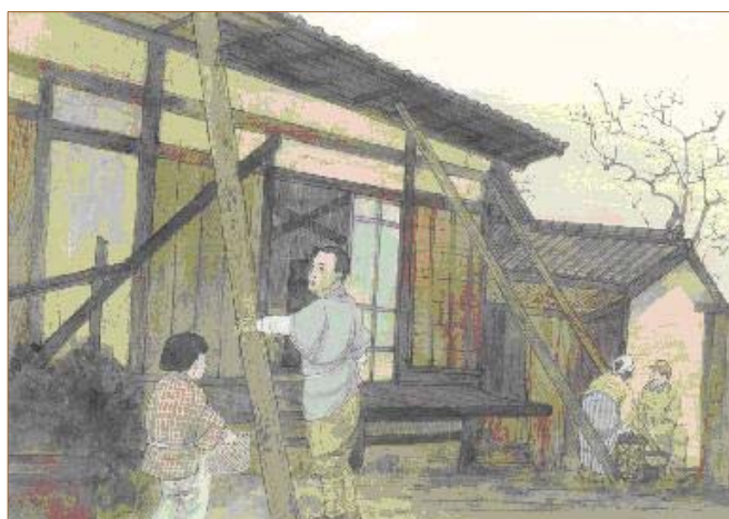
図 6-6 黒柳岩治さんの体験談をもとに作成した絵画（阪野智啓氏作画） 「東南海地震後、簡単な補強だけで家を使っていた。三河地震の揺れで一瞬にして家が倒壊してしまい同じ部屋で寝ていた5人が亡くなってしまった。」
