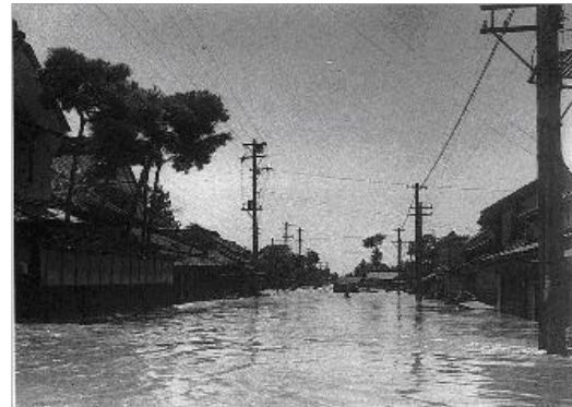
写真 1-10 権現堂村（現・幸手市）の浸水 （出典：写真 1-7 に同じ）
