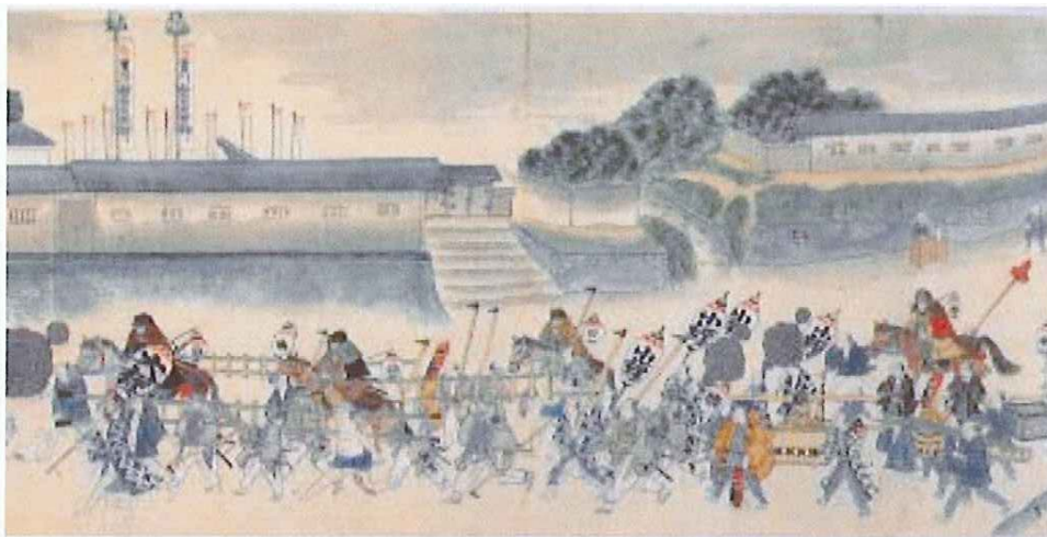
図 4-4 定火消の出動の様子 『鎮火安心図巻』(嘉永年間頃の、江戸の町の火災と消火活動の様子を描いた絵巻物)より(国立国会図書館所蔵)
