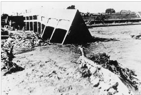
写真 1-3 新川グラウンドの崩壊（「カスリーン 災害記録集」 渡良瀬川河川事務所、1999）
