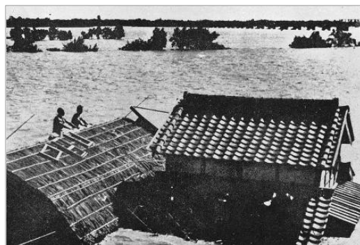
写真 1-8 屋根の上に避難する人々 （栗橋町）（「付録写真録」埼玉県、1950 年）
