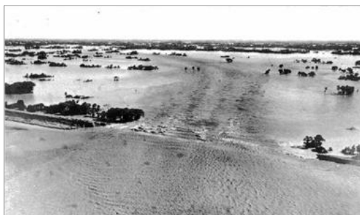
写真 1-7 利根川右岸埼玉県東村での 越水・決壊 （国土交通省利根川上流河川事務所）
