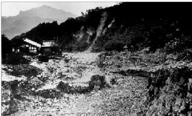
写真 1-1 昭和 22 年カスリーン台風による 沼尾川の被害（群馬県旧赤城村深山） （利根川水系砂防事務所HPより）
