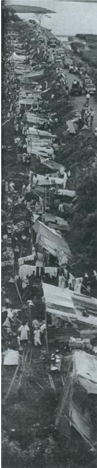
写真2-7 庄内川堤防に急 設した避難小屋(9月27日) (出典は図2-3に同じ)
