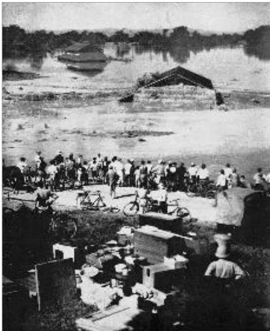
写真 1-9 堤防上より濁流を見る人々 （幸手市）（出典：写真 1-8 に同じ）
