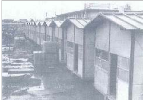
写真 5-3 応急仮設住宅の設置 (出典:写真 5-2 に同じ)
