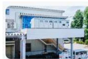
受電変圧施設の高床化
