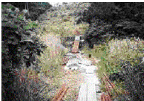
写真 湿地の上に板を敷いただけの初期の避難路
