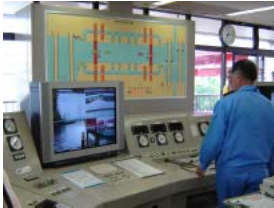
閘門操作の説明の様子
