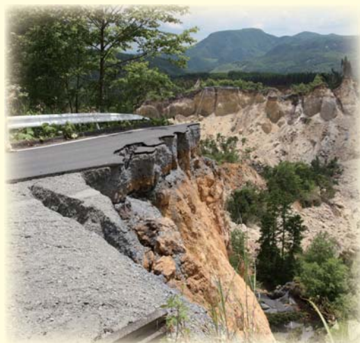
(崩落現場：宮城県栗原市提供)
