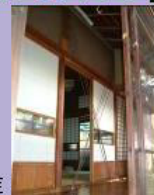
耐震補強工事の一例
