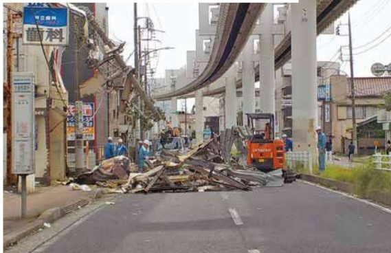
倒壊したプレハブの撤去作業 (稲毛区作草部1丁目)
