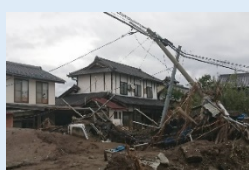
令和元年東日本台風後の長沼地区の様子
