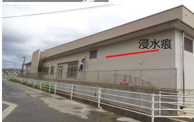
浸水した真備健康福祉プラザ
