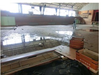
浸水した川辺小学校体育館
