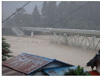
紀伊半島大水害時の折立橋の被害
