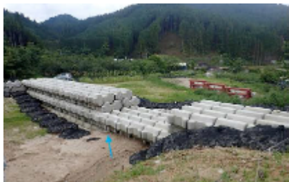
土砂を受け止める砂防ダム
