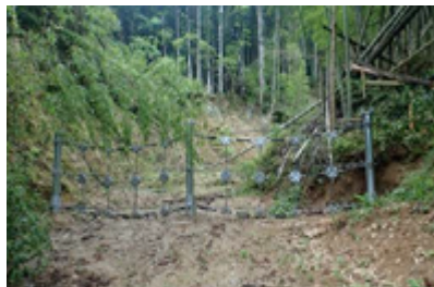
流木止のフェンス
