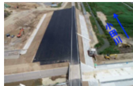
堤防の幅を広くして補強
