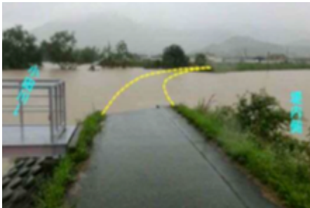
小田川堤防決壊箇所
