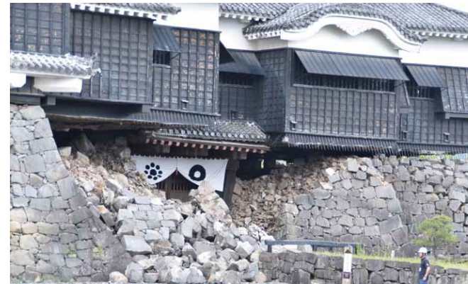
熊本城天守石垣の崩落
