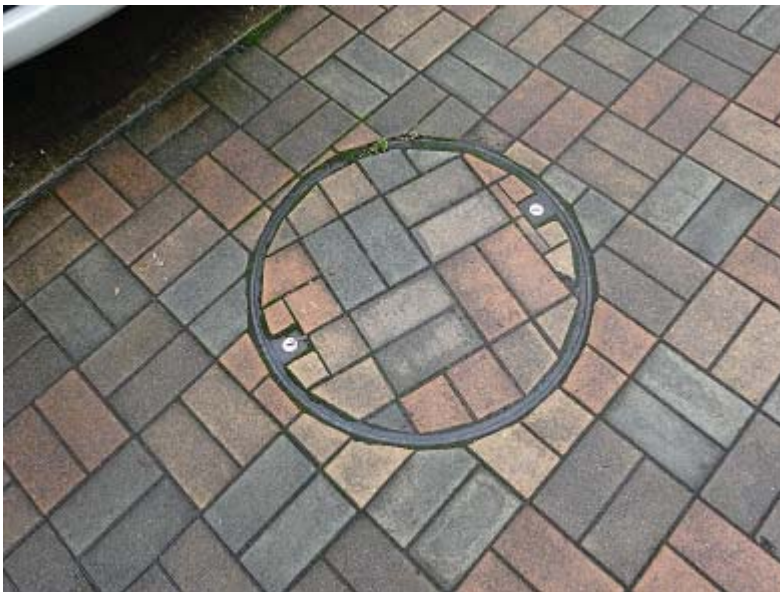
汚水枥（マンホールトイレ設置位置）
