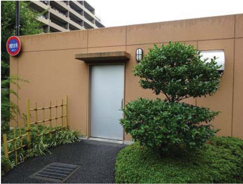
防火水槽（40 トン）
