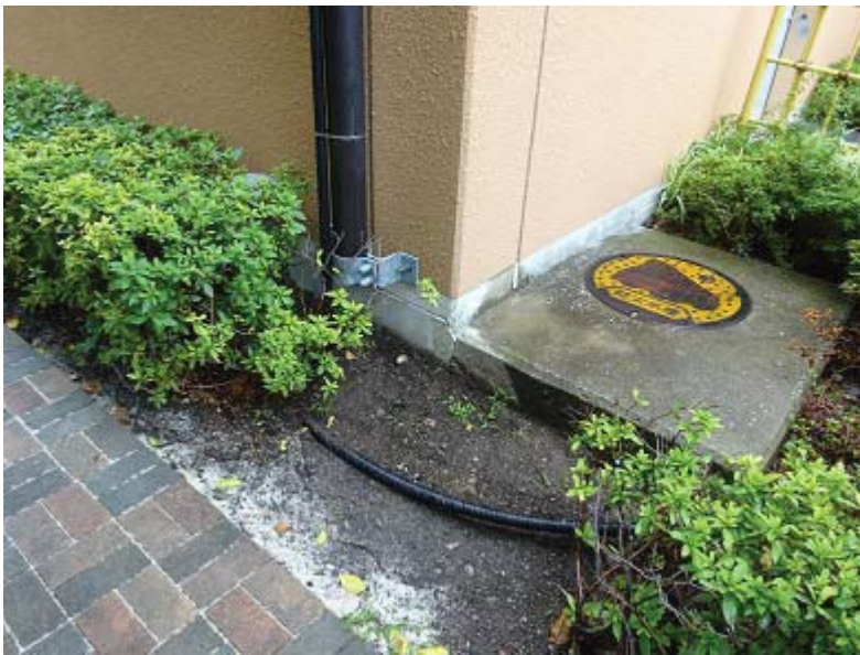
CATV 引き込み位置
