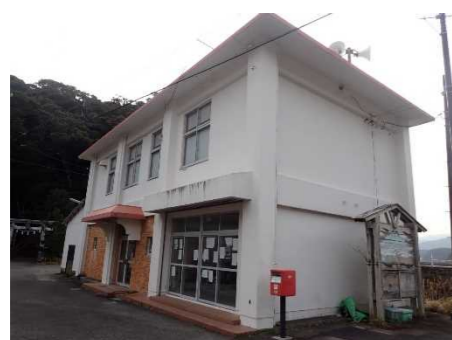
竹ヶ島生活改善センター 2階
