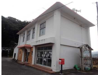
竹ヶ島生活改善センター 2階以上
