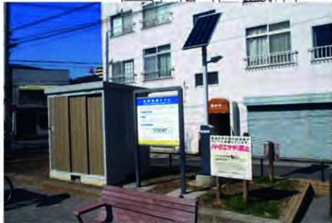
千住中居町公園の災害トイレ
