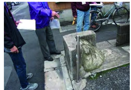
曲がり角がコンクリートでかためられてしまって車（緊急車両）が曲がれない
