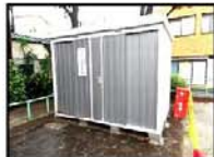
5 防災区民組織資材格納庫
