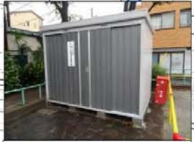
防災区民組織 消防隊資材格納庫 (千住柳町児童遊園内)
