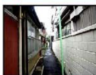
19 狭すぎる道に高いブロック塀
