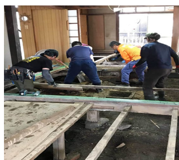
床下の泥出し
