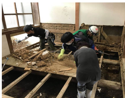
床板の除去作業
