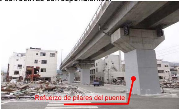
Estado del puente, luego del Gran Terremoto de Este de Japón (con medidas de refuerzo antisísmicos previamente aplicadas)
