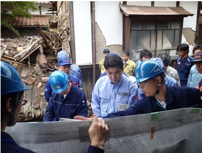
住宅倒壊現場 【北栄町】
