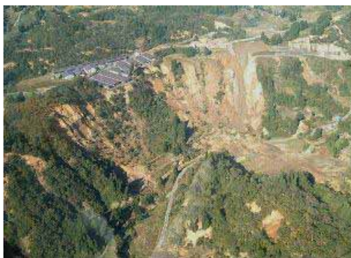
新潟県中越地震の際の土砂崩れ
