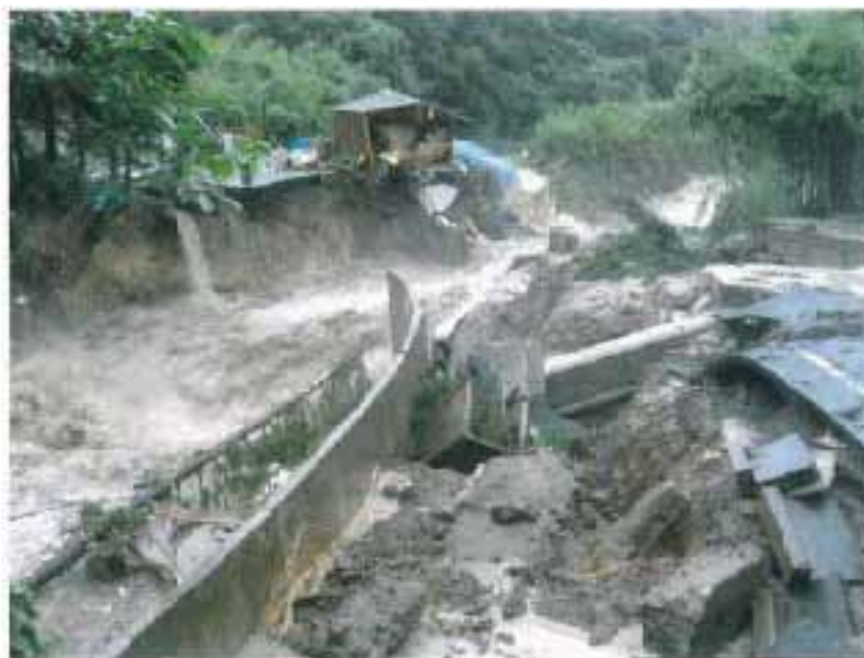
平成18年7月豪雨の大口市の被災状況
