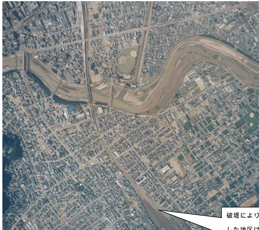
図 3 水害時の航空写真(足羽川：福井市)
