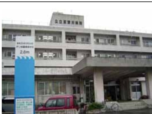
②公立志津川病院屋上を指定（手前は昭和 35 年チリ地震津波水位：2.8m）
