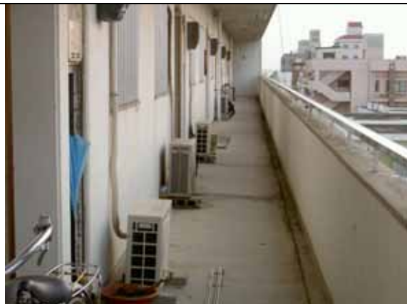
⑥民間避難ビル（蓬菜閣マンション）の避難場所（各階共用廊下部分）
