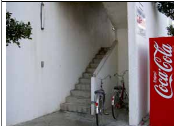
⑤民間避難ビル（蓬菜閣マンション）の外階段
