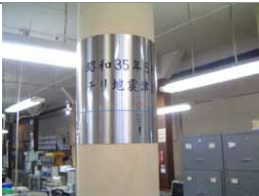
①志津川町役場 1 階の柱に記された昭和 35 年チリ地震津波の浸水実績
