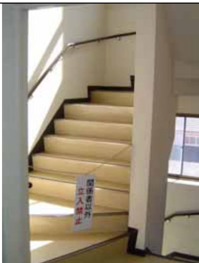
③ （3F→屋上）立入禁止の札
