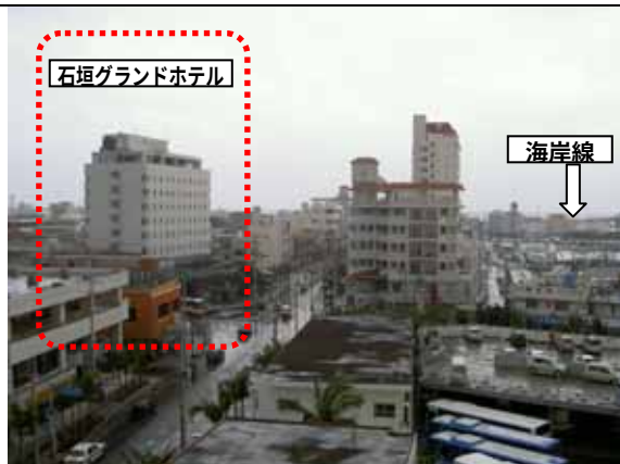
④民間避難ビル（左手・石垣グランドホテル）海岸線より2列目で指定
