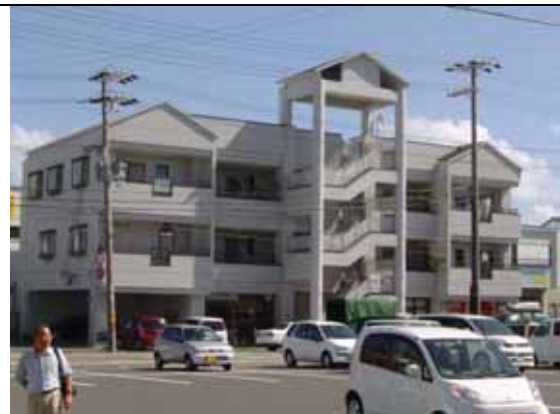
⑤ 津波避難ビル（民間施設）（その 2）
