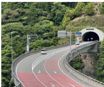
令和元年(2019年)開通の今戸高架橋と十津川温泉北トンネル(令和8年(2026年)6月撮影)
