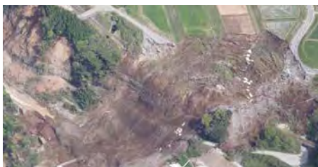
本震発災後の平成28年(2016年)4月16日午前に国土地理院が撮影した写真。南阿蘇鉄道の線路に崩れた土砂が流入している(国土地理院)
