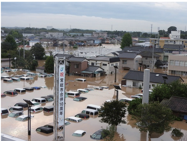
冠水した市役所の駐車場（常総市提供）
