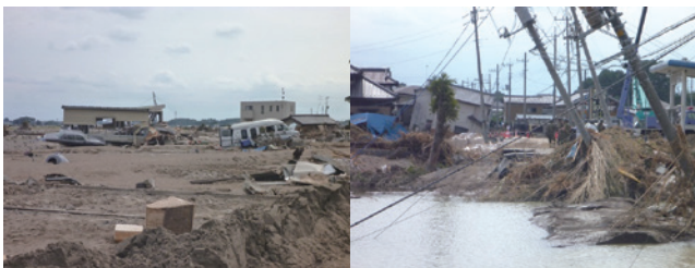
決壊地点周辺の被害状況（常総市提供）
