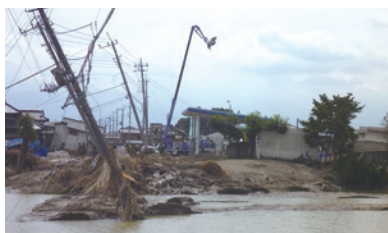
上三坂町の堤防決壊箇所付近の被害状況（提供：常総市）
