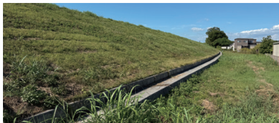
堤防の裏法。法尻には浸透した水を排水するドレーンが設置されている（令和7年（2025）年9月撮影）
