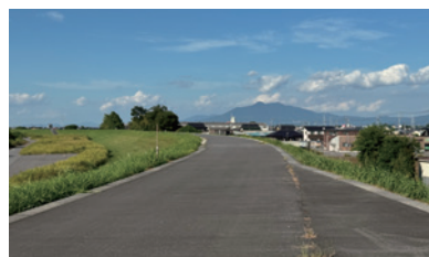
復旧した堤防の天端。表面は舗装され、法肩にはブロックが施され強化されている（令和7年（2025）年9月撮影）
