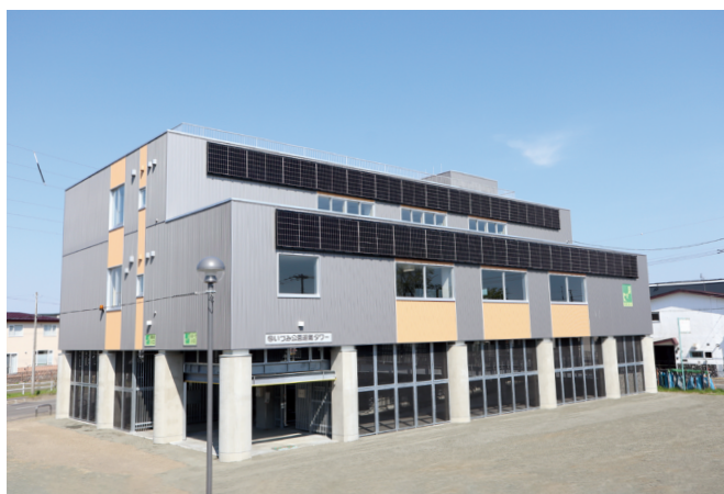
いづみ公園避難タワー（外観）
