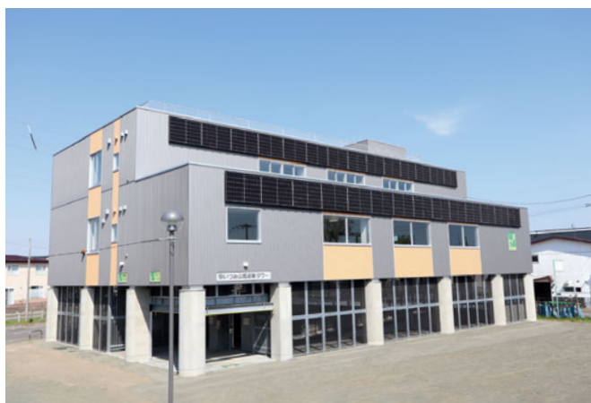
いづみ公園避難タワー（外観）
