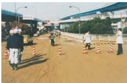
ポートアイランドをつなぐ神戸市中央区の神戸大橋付近の液状化被害(写真提供:神戸市)と現在(令和7年(2025年)1月撮影)
