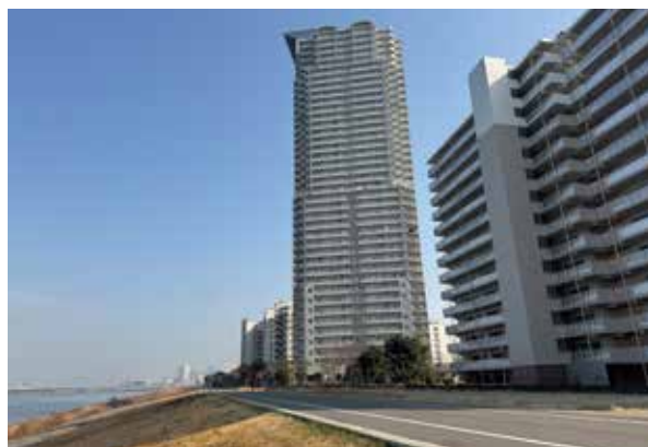
▲スーパー堤防が整備された現在の西島（令和7年（2025年）1月撮影）
