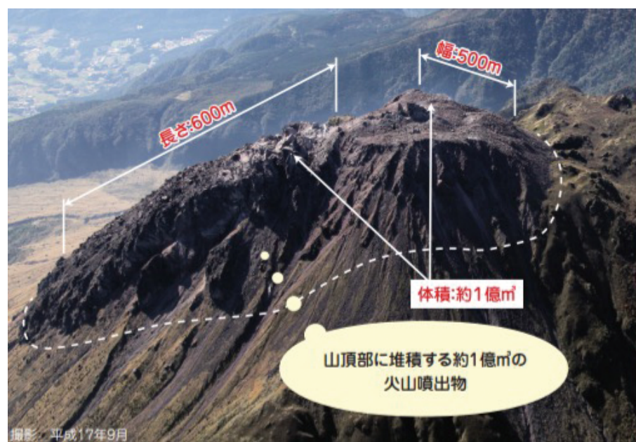
写真1 今でも存在する溶岩ドーム崩壊の危険性
