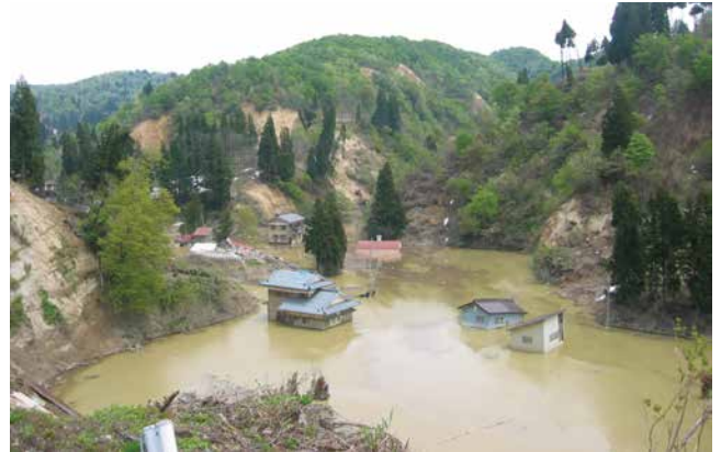
東竹沢地区で発生した芋川の河道閉塞により水没した木籠集落(長岡市提供)
