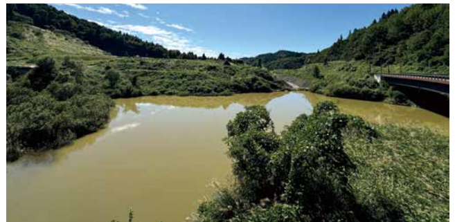
現在の東竹沢地区の河道閉塞跡。写真中央の平坦な部分が地すべり堆積塊。その右手には放水用の水路が開削されている。(2024年9月撮影)
