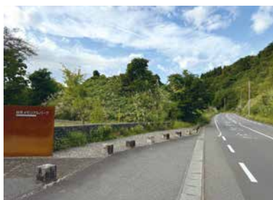
長岡市妙見の崩落の様子(長岡市提供)。現在県道は堆積した土砂を切通しで抜ける形に変更されており、現場付近には妙見メモリアルパークが整備されている。(2024年9月撮影)
