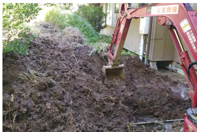
土砂の撤去作業現場
