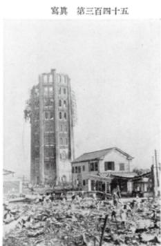
地震の激しい揺れで、8階から上が折れる形で大破、中にいた人の多くが犠牲になりました。倒壊の危険があるため、その後爆破解体されてしまいました。
