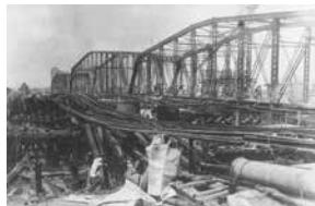
永代橋の被災前(上:東京名所絵葉書より)と被災後(下:土木学会附属土木図書館提供)。橋底や橋板が木造だったため、トラス部を残して焼失した
