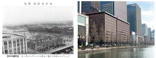
完成を目前に倒壊した内外ビルディングの様子(土木学会附属土木図書館提供)。現在は丸の内三井ビルディングが建つ
