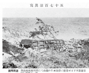
国産院蔵 111号車の一部
