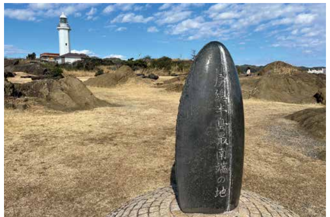
倒壊した野島崎灯台(土木学会附属土木図書館提供・写真上)と現在の野島崎灯台(写真下)
