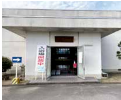
【静岡刑務所武道場】
