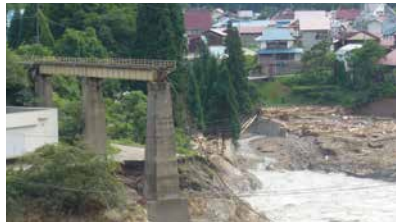
被災直後の第六只見川橋梁(ダム側から撮影)。橋脚やトラス桁、桁橋が流失している(提供:福島県金山町)
