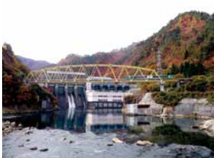
本名ダムをバックに第六只見川橋梁を渡る只見線の列車
