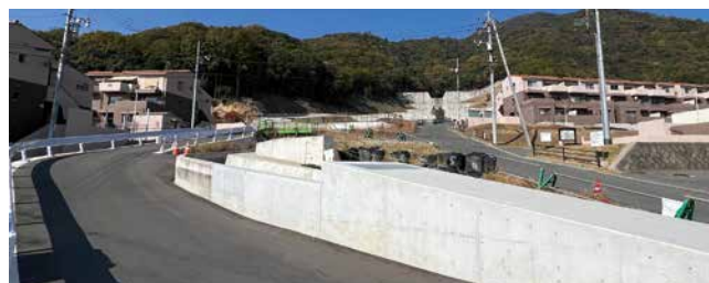
広島市八木地区の県営緑丘住宅付近の土砂災害被災後の平成26年（写真上）と現在（令和4年（写真下））の比較。土石流が通りやすい谷筋は住宅を建てず道路として利用しており、背後には砂防堰堤が築かれている。このすぐ横に自然災害伝承碑が残されている（写真左）
