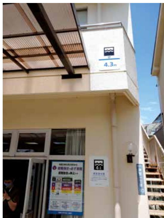
地区パネル設置
