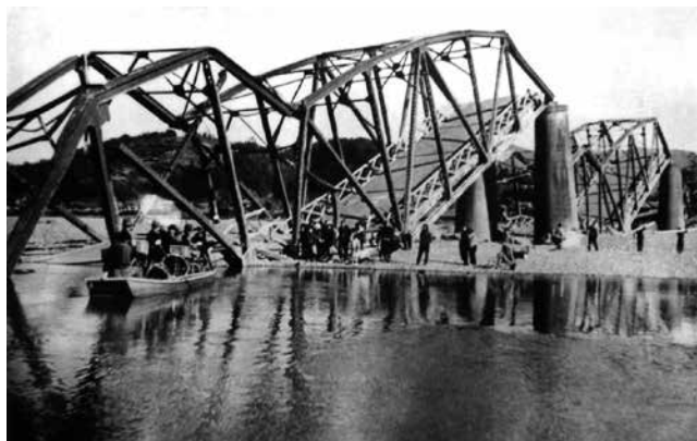
高知県幡多郡中村町（現四万十市）四万十川鉄橋落橋
