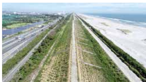
防潮堤の整備（浜松市）
