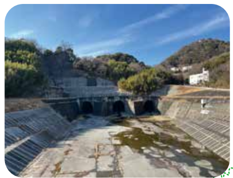
長岡トンネル壩之上側の坑口
