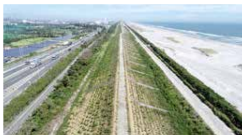
防潮堤の整備（浜松市）
