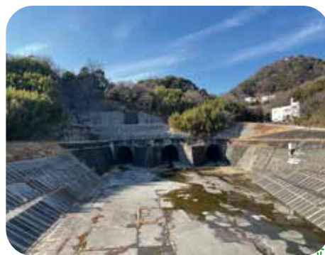
長岡トンネル壩之上側の坑口
